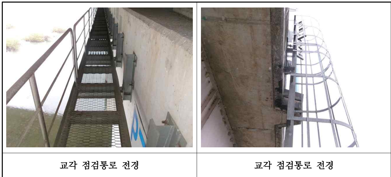
【사진 1.3.25】 교량 점검시설 전경
