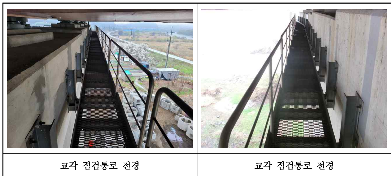
【사진 1.3.50】 교량 점검시설 전경
