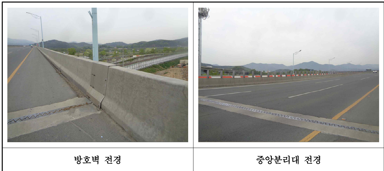
【사진 1.3.23】 방호벽 및 중앙분리대 전경
