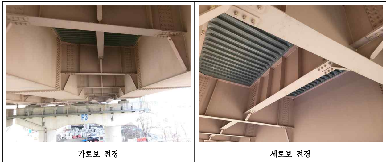
【사진 1.3.6】 가로보 및 세로보 전경
