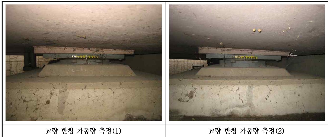
【사진 1.3.15】교량받침 이동량 측정
