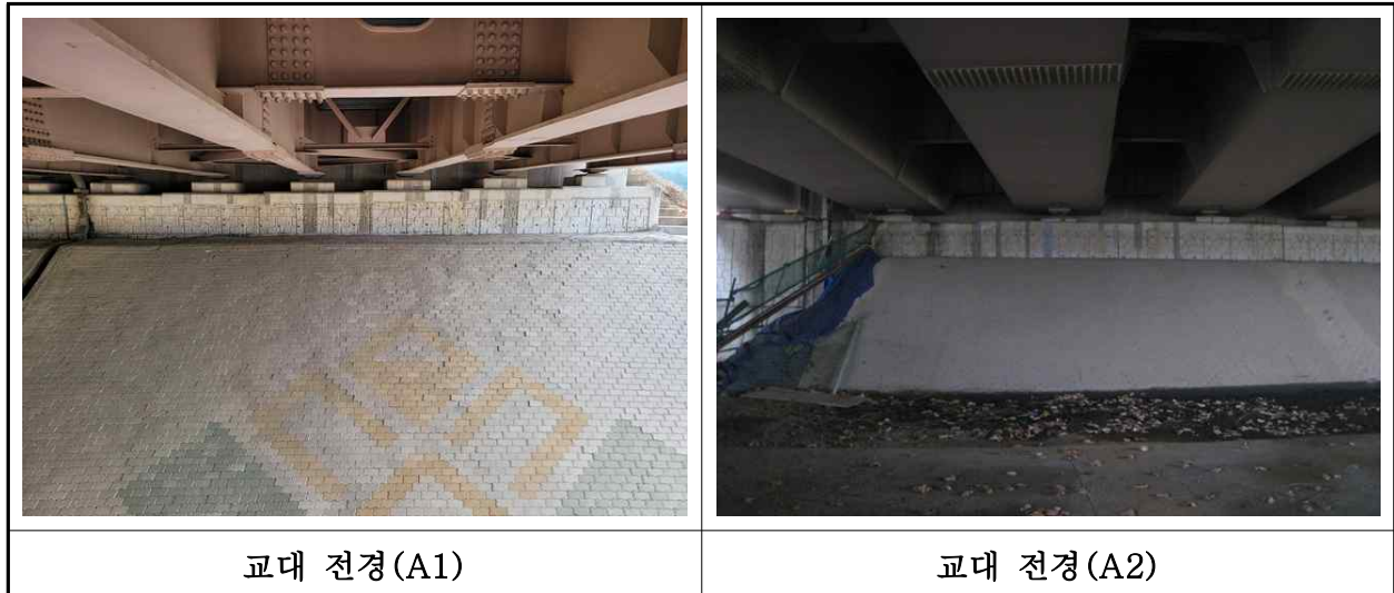
【사진 1.3.8】 교대 전경
