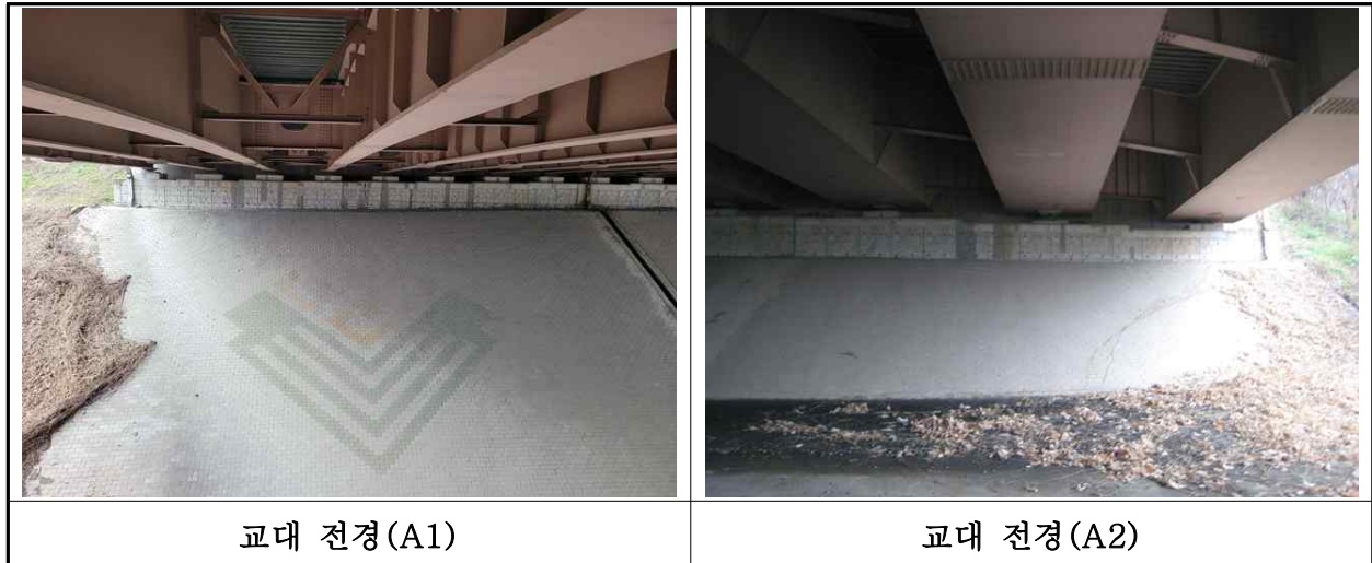
【사진 1.3.33】 교대 전경
