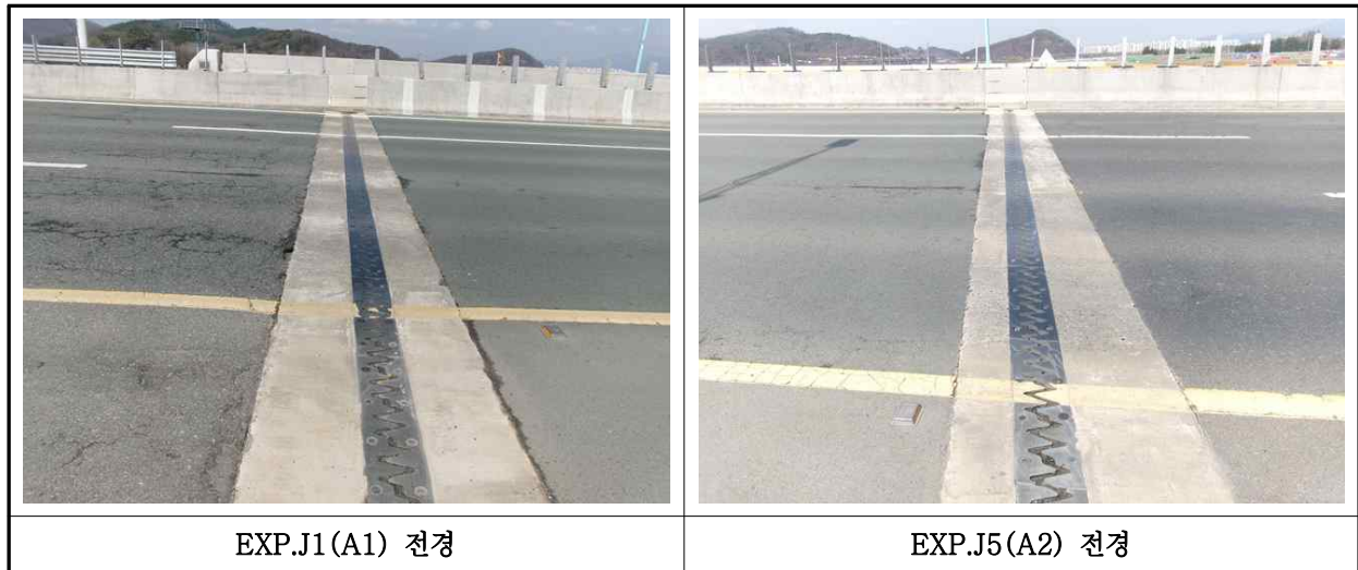
【사진 1.3.41】 신축이음장치 전경
