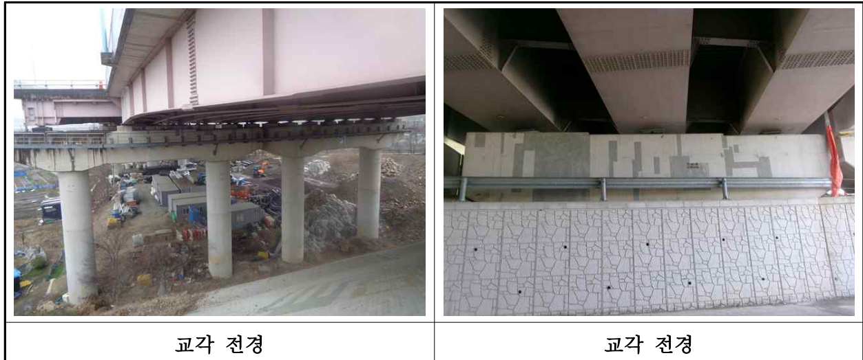
【사진 1.3.10】 교각 전경
