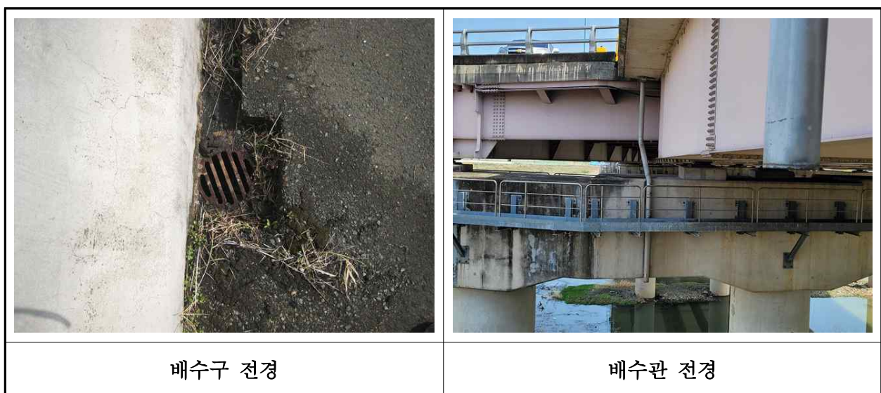
【사진 1.3.21】 배수시설 전경
