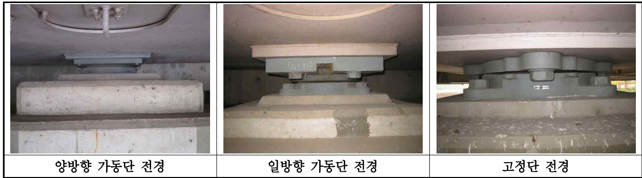
【사진 1.3.12】 교량받침 전경
