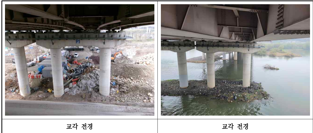
【사진 1.3.35】 교각 전경
