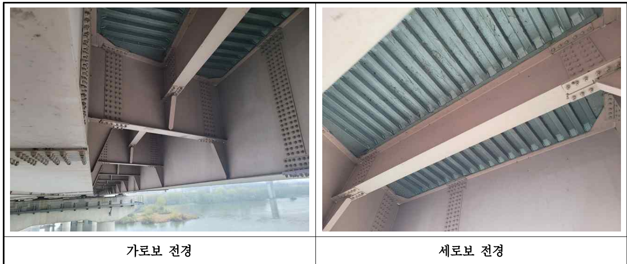
【사진 1.3.31】 가로보 및 세로보 전경
