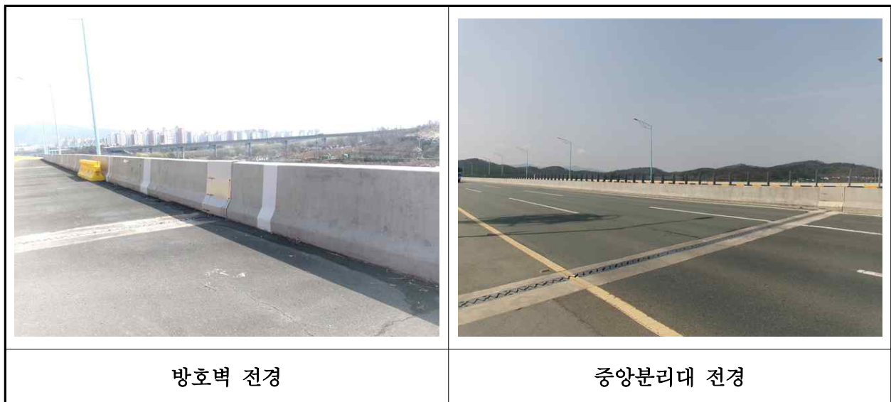
【사진 1.3.48】 방호벽 및 중앙분리대 전경
