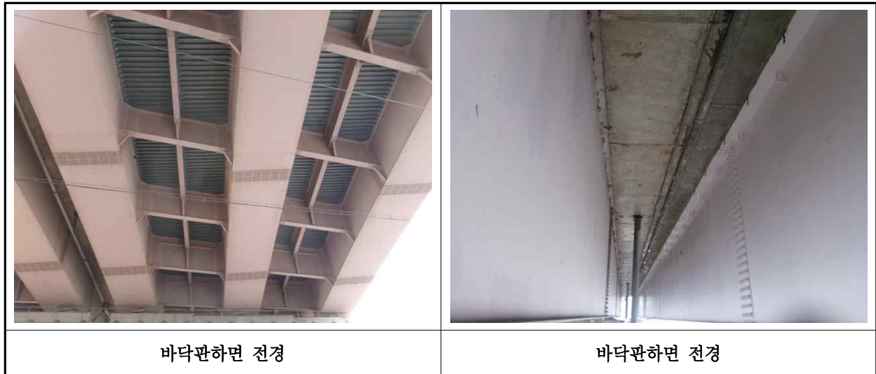
【사진 1.3.2】 바닥판하면 전경
