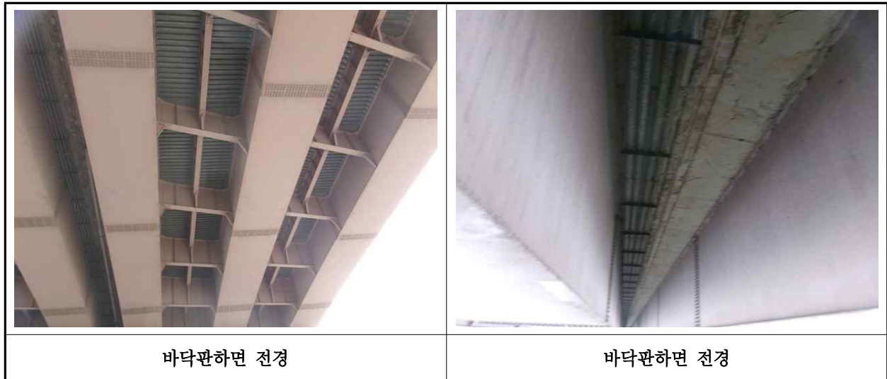
【사진 1.3.27】 바닥판하면 전경
