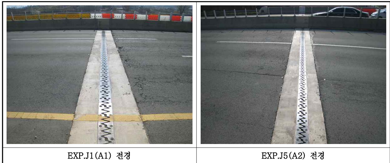
【사진 1.3.16】 신축이음장치 전경
