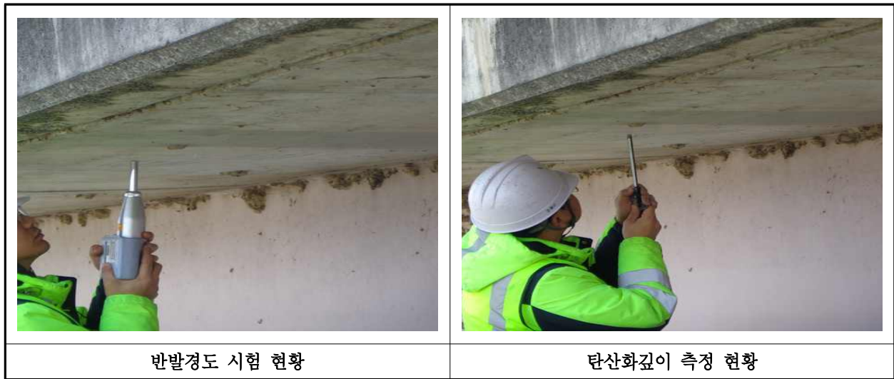
【사진 1.4.1】 콘크리트 내구성조사 현황
