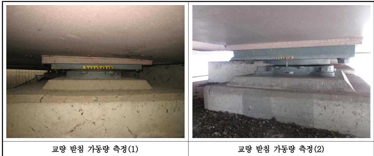
【사진 1.3.40】 교량받침 이동량 측정
