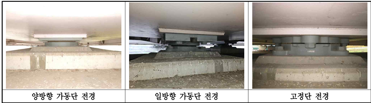
【사진 1.3.37】 교량받침 전경
