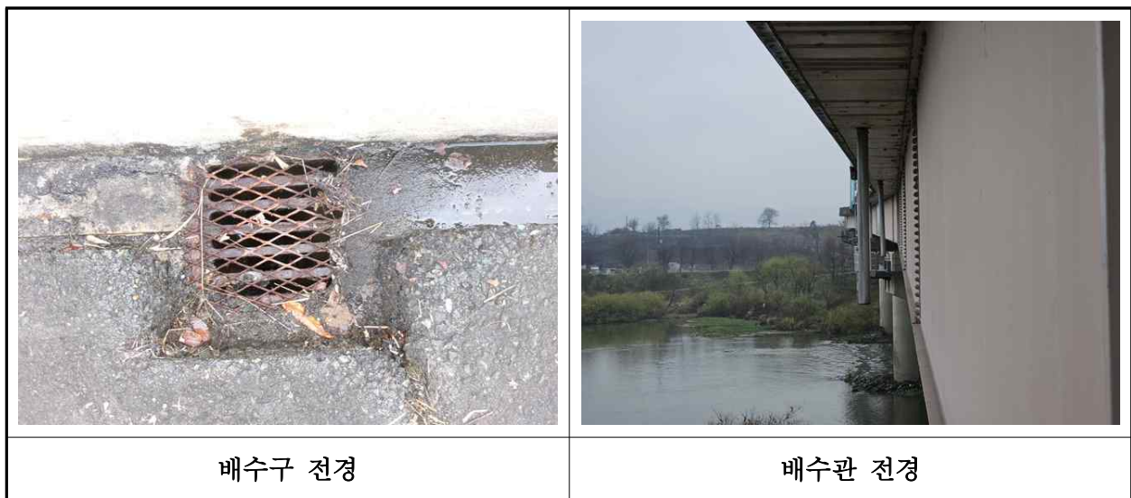
【사진 1.3.46】 배수시설 전경
